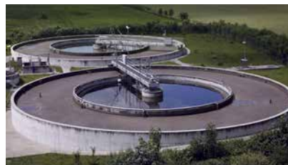
Acque di scarico Waste water SMP 400 SBT
