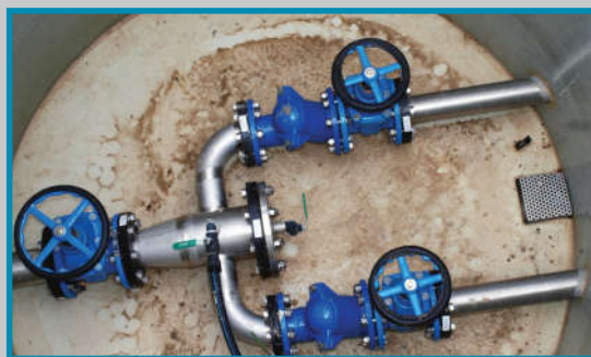
Ventilbrønden indvendig med gulvafløb
