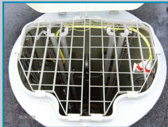
TOP brønd med guiderør. Her med sikkerhedsriste i rustfrit stål.
