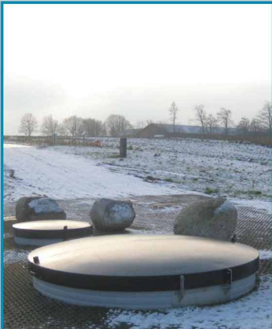
Sort elokseret aluminiumsdæksler med positiv bue, så regnvandet falder af.
