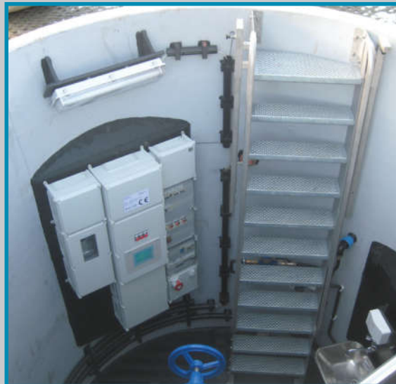
Skrå aluminiums trappe med gelænder i side, der kan trækkes op over terræn.
