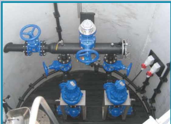
Pumper, ventiler etc. er let tilgængeligt. Rensegris er med brugervenlig quicklås. Dvs. med vingemøtrikker der kan løsnes med håndkraft.
