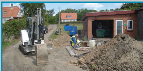
Ombygningen er i fuld gang. I baggrunden kan den blå mammut, der klarede ompumpningen, ses.
