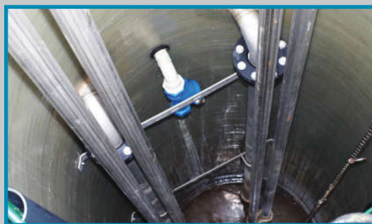
Ventilbrønden indvendig med gulvafløb
