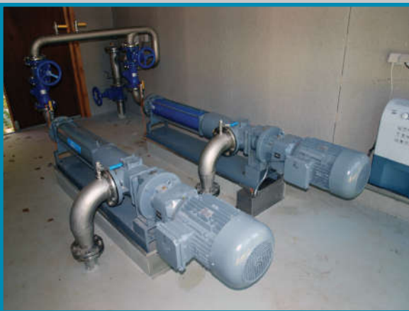
2 tørtopstillede snekepumper
