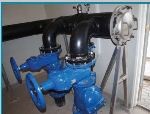
Sendestationen til rensegrise har "Quicklås", dvs. vingemøtrikker der kan løsnes med håndkraft.
