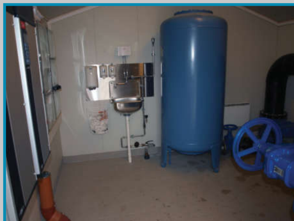
Væg til automatiskabe, håndvask samt membranbeholder.
