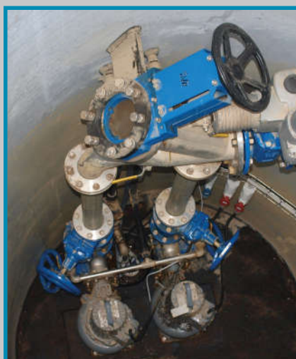
Indvendig ses her de tørtopstillede pumper & ventiler.
