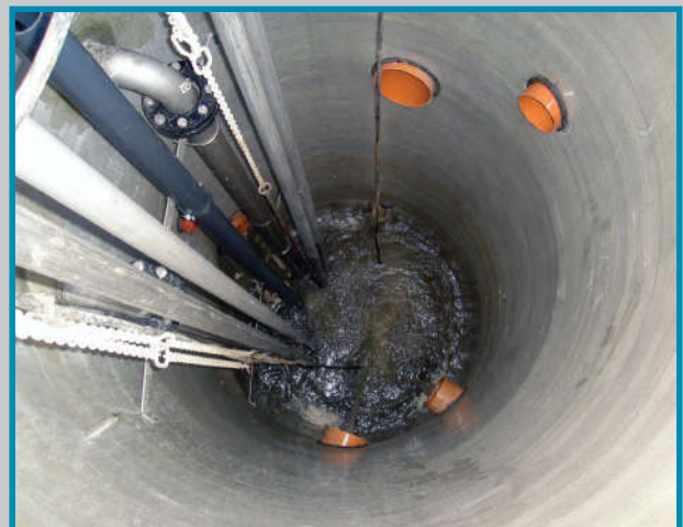
Den nye brønd indvendig. Helt rene og glatte sider, hvor slam ikke kan sætte sig fast.
