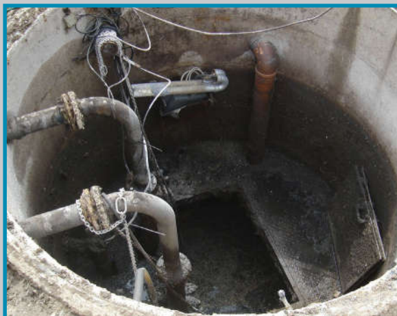
Den gamle betonbrønd, med mellemdæk.
