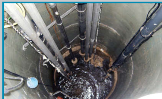
TOP brønd med guiderør. Her med sikkerhedsriste i rustfrit stål.
